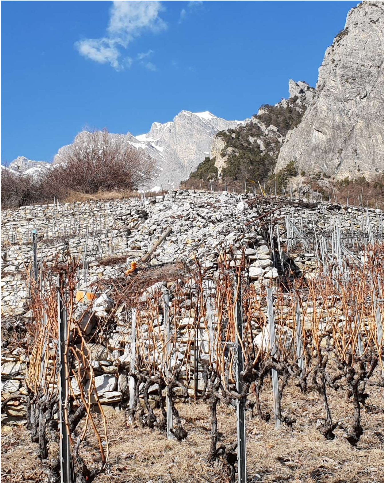
Photo 13.- Bocaille remplissant le rempart entre les deux parements. (D. Masotti)
