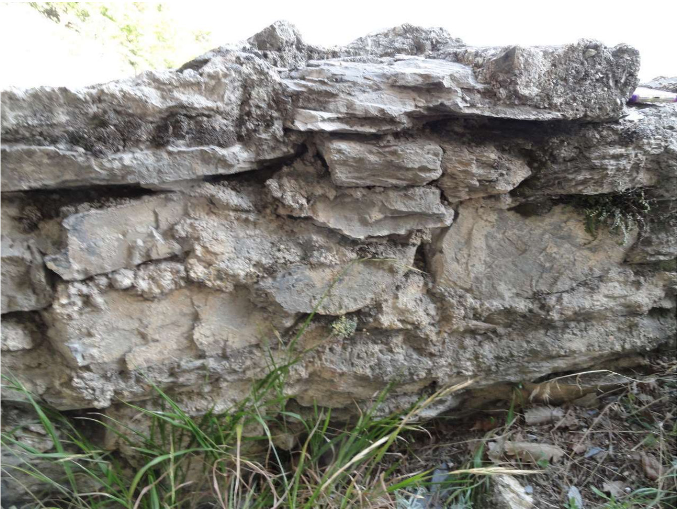
Photo 8.- Mortier liant les pierres, toujours sur le même mur de fortification, vu de l'intérieur, depuis la plaine. La datation au carbone 14 a été effectuée sur ce mortier. (Christian Rey)
