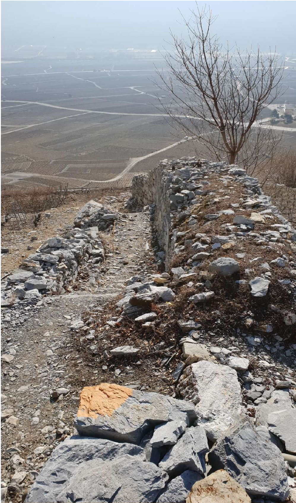
Photo 14.- Cheminement à l'intérieur du rempart. (D. Masotti)
